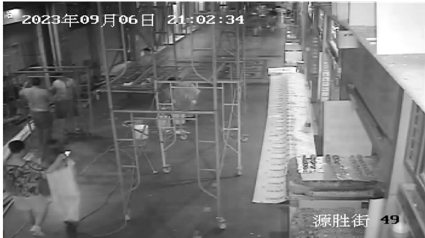
图7 朱某某、汪吉生、聂某某开始搭设移动门式作业架 (图显时间约慢1分钟)
