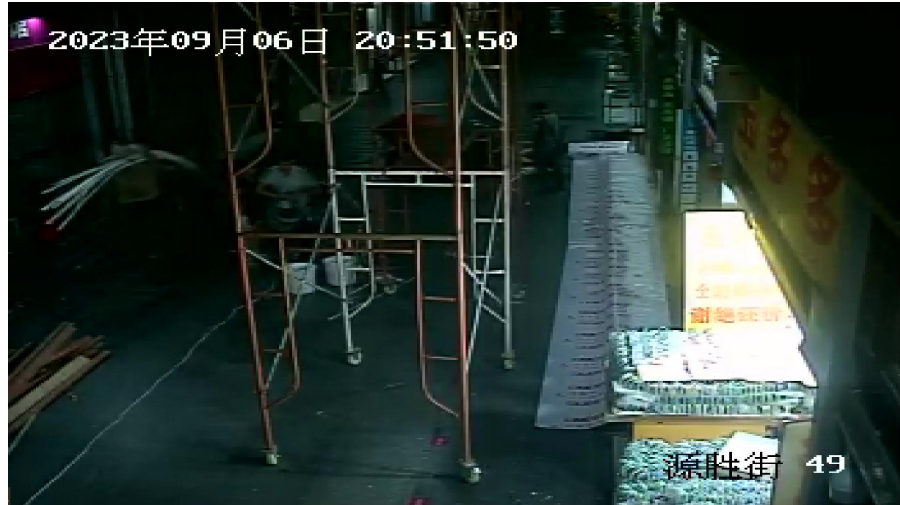
图5 汪吉生将线管线槽搬运至源胜街通道 (图显时间约慢1分钟)
