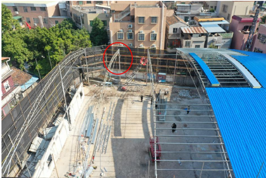
图 6 事发前凌某某在东北角第二根槽钢立柱进行桁架牛腿加固烧焊作业
