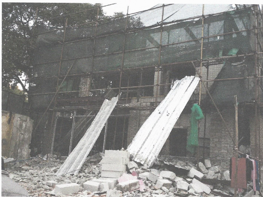
(2019年1月23日, 鹤洞路265号改建、扩建部分当事人自行拆除)
