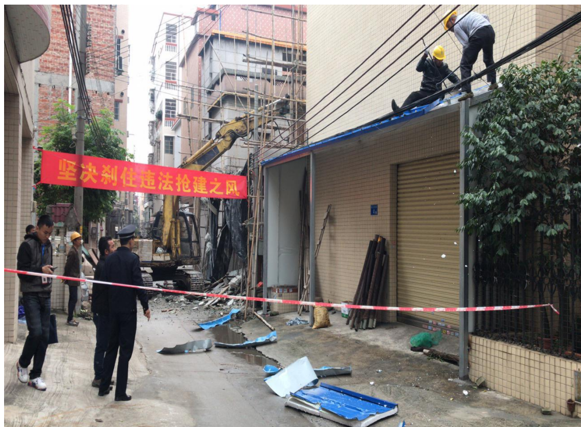
附件 2：3 月 15 日拆违现场照片
