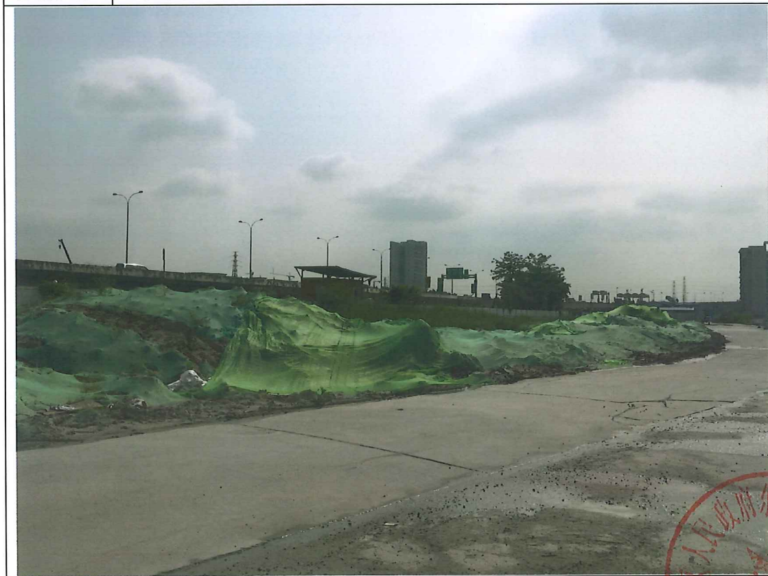
拍摄说明 | 立白集团综合科技园工地裸土已覆盖绿网并洒水降尘
