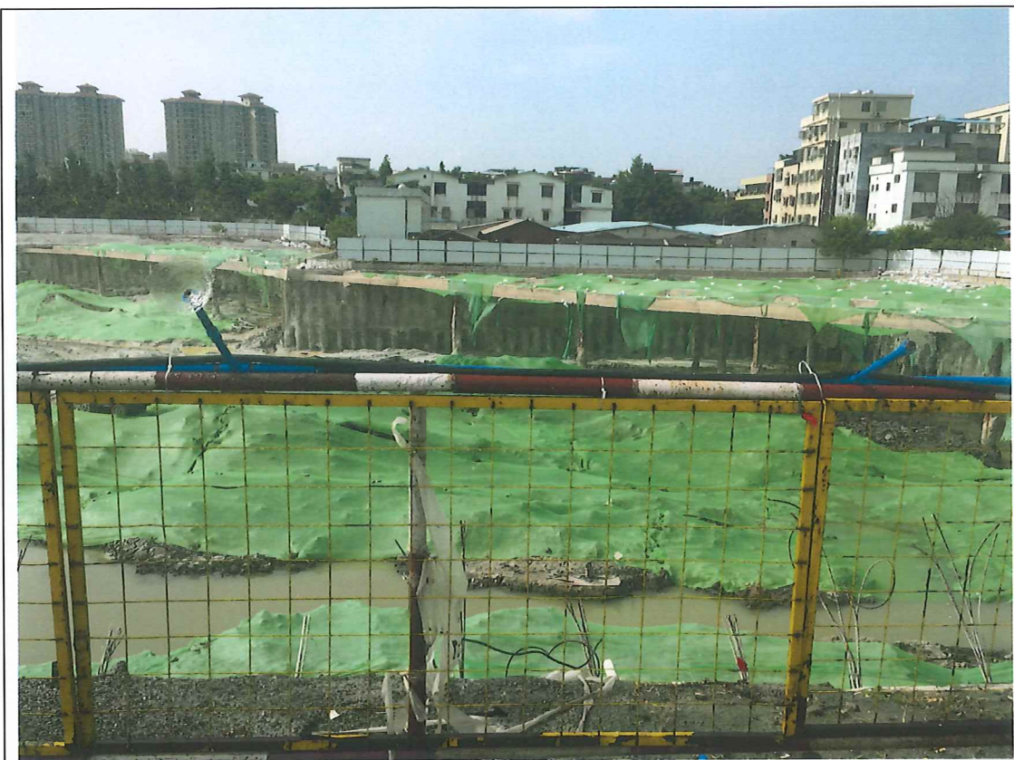
拍摄说明 | 立白集团综合科技园工地喷淋系统已开启
