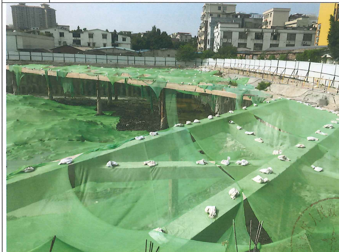
拍摄说明 | 立白集团综合科技园工地裸土已覆盖绿网
