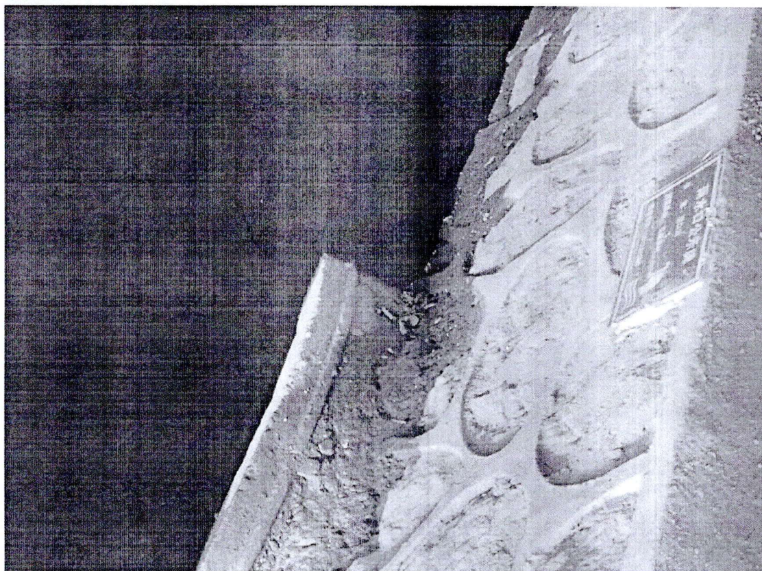
图 7 逸彩新世界小区排水口无污水排出
